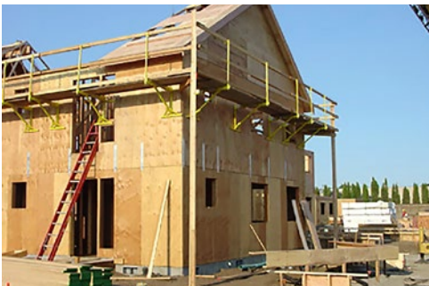
Andamios de ménsula exteriores de carpintero prefabricados.
