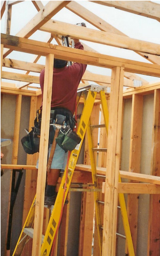
Trabajo en la cúspide desde la placa de apoyo superior de una pared interior.
