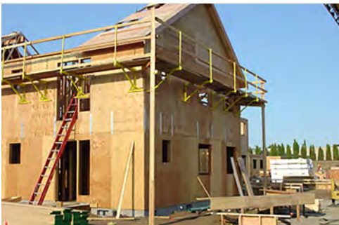
Andamios de ménsula exteriores de carpintero prefabricados.
