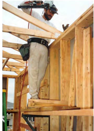
El constructor de la vivienda diseñó las ménsulas del andamio interior.
