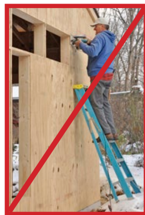
Escalera estándar usada en una configuración no aprobada
