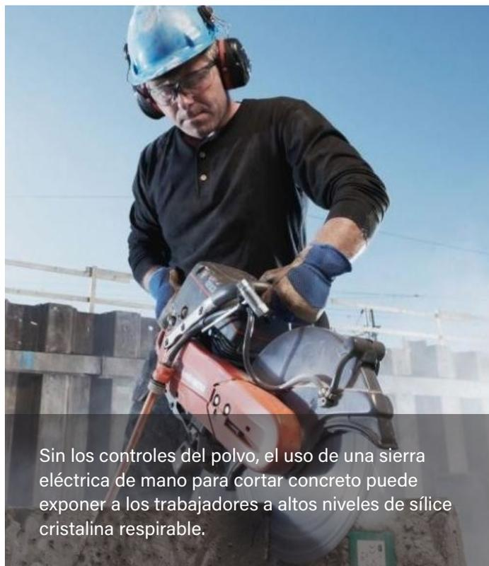
Sin los controles del polvo, el uso de una sierra eléctrica de mano para cortar concreto puede exponer a los trabajadores a altos niveles de sílice cristalina respirable.
