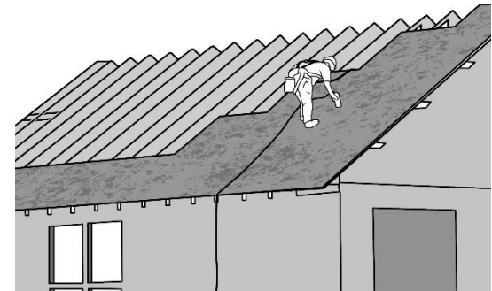
ROOF SHEETING LA CUBIERTA DEL TECHO
